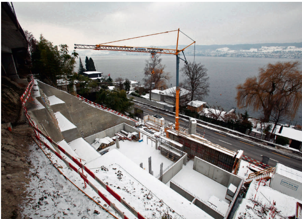
Eine Million Franken kostete allein das Fundament – ein von Menschenhand geschaffener Felsen, an dessen Fuss ein Betongerippe auf den Frühling wartet. Foto: Patrick Gutenberg
